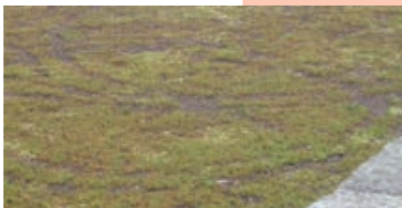
Toiture terrasse végétalisée
