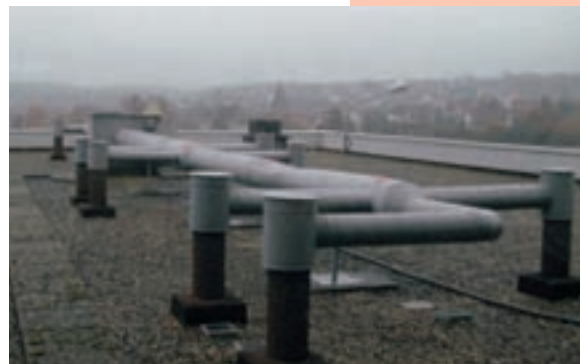
Toiture-terrasse inaccessible avec zone technique
