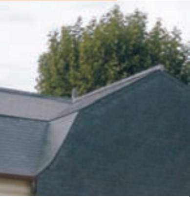
couverture en ardoise
