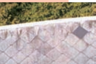
couverture en ardoise artificielle
