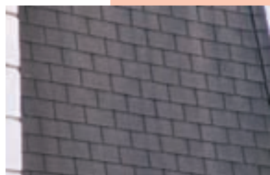
couverture en bardeau bitumé
